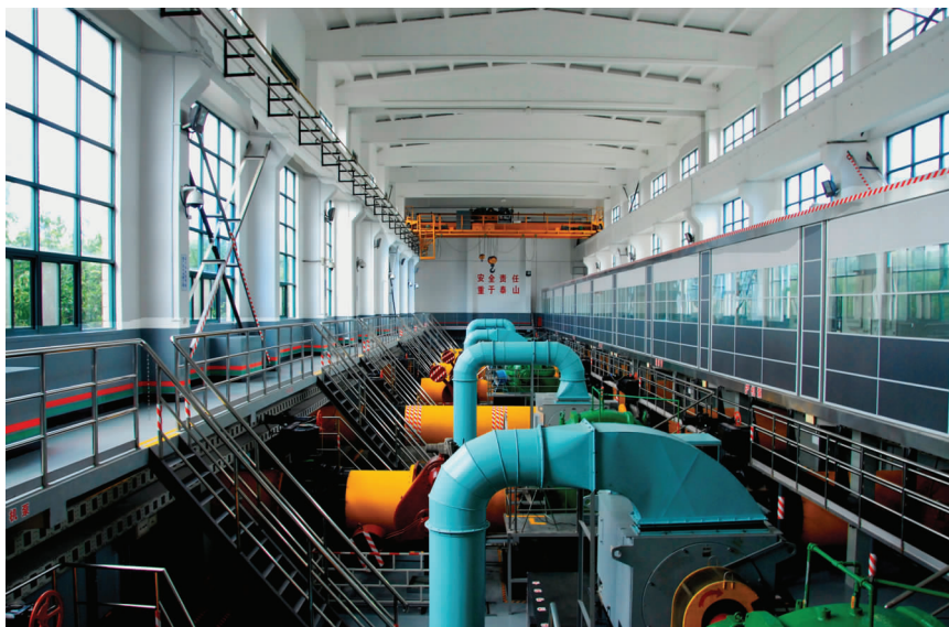
长江原水厂取水泵房
