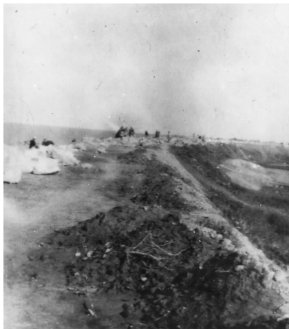
1949 年台汛中被全线冲毁的宝山海塘 区档案馆/提供
