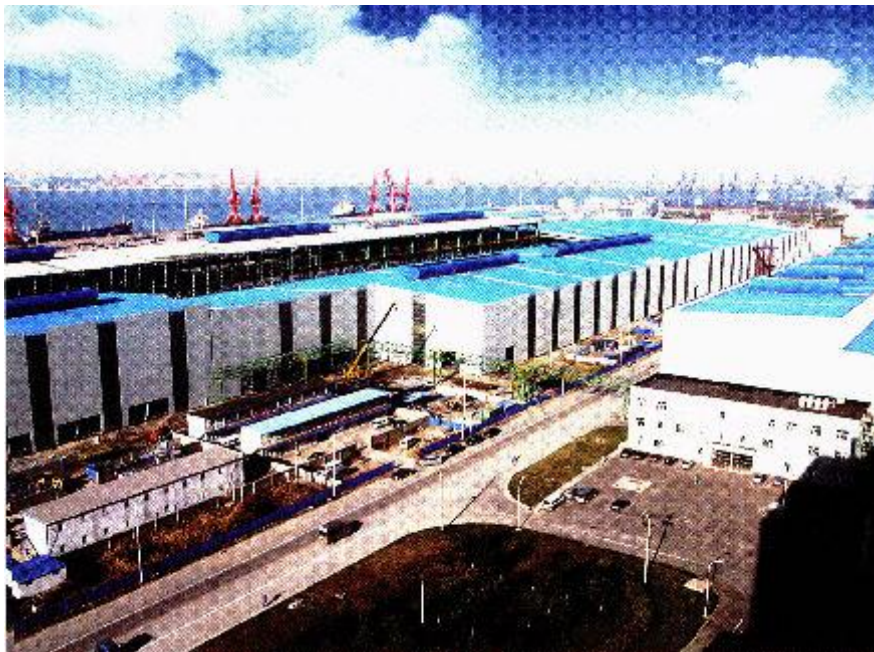
上海五冶承建的首钢京塘三冷轧镀锡精整工程摄影 / 王晨辉
